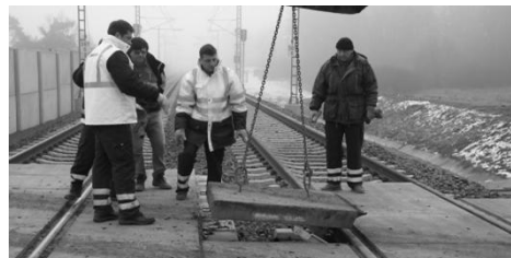
Demontáž přejezdových panelů
