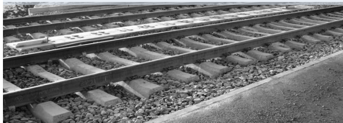
připravená trať pro strojní podbíjení se stabilizací a akustickým broušením
