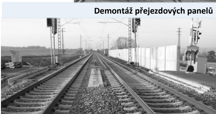
připravená trať pro strojní podbíjení se stabilizací a akustickým broušením
